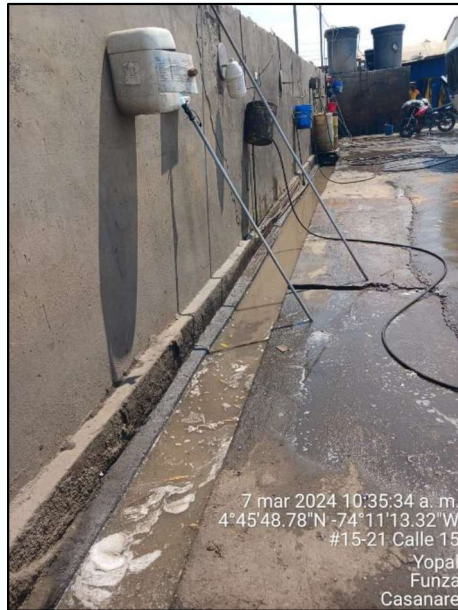
Ilustración 7. Canal y trampa de grasas
